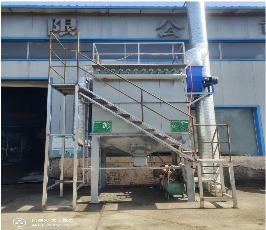
图 4-1 布袋除尘器+15 米排气筒
