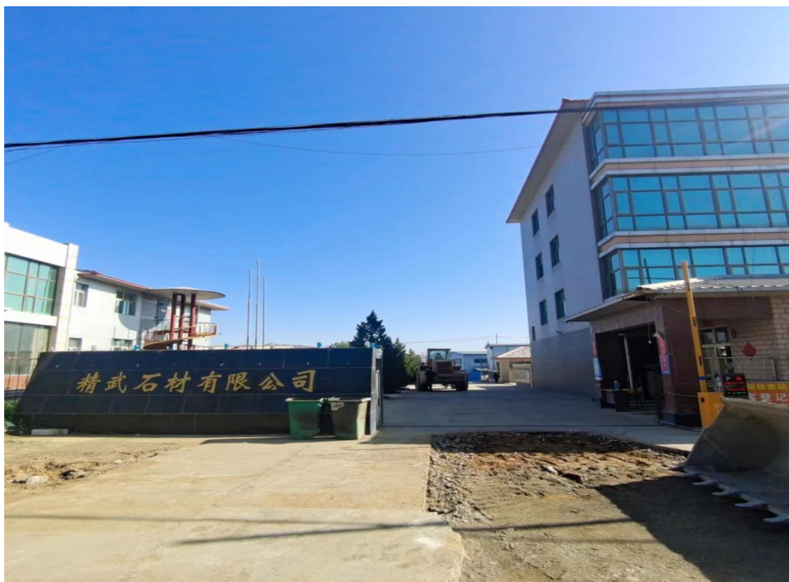
怀安县精武石材有限公司怀安县艺术石雕文化产业园项目主体工程现场彩色照片
