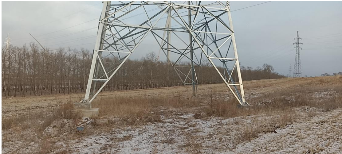
塔基临时占地恢复情况
