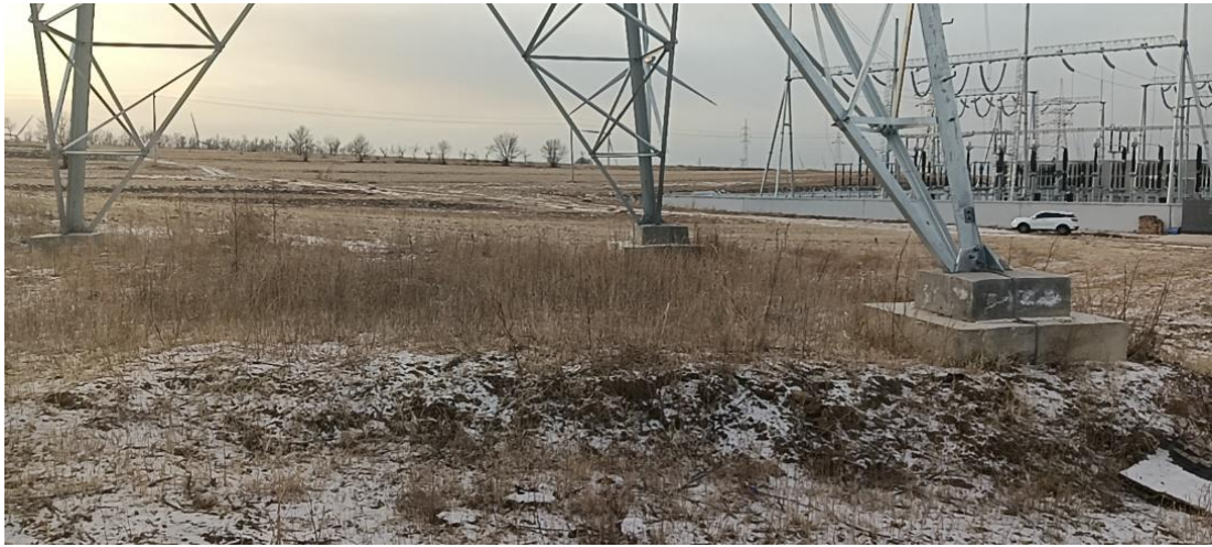
塔基临时占地恢复情况
