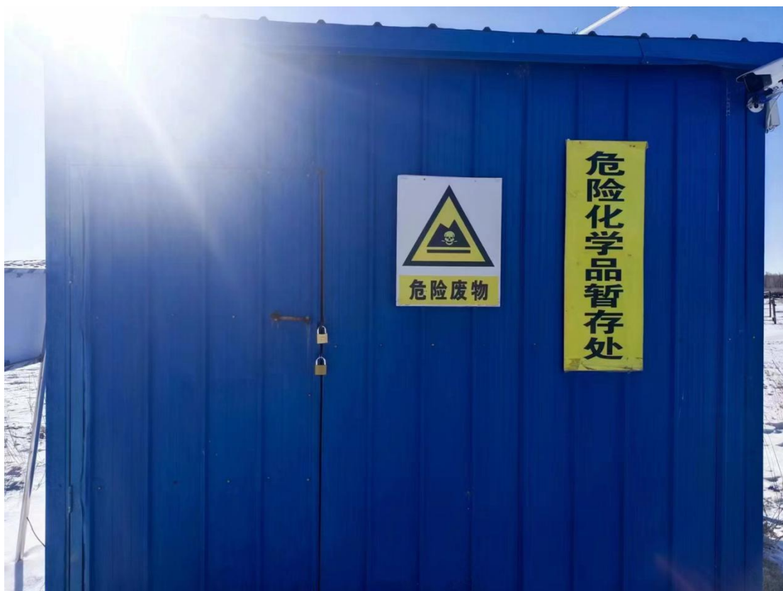
图 3-3 危险废物暂存间现场照片
