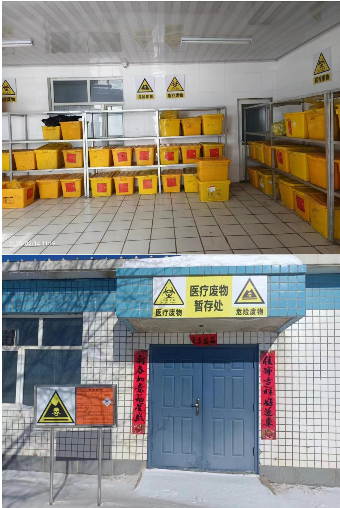
图 3-2 医疗废物暂存间现场照片
