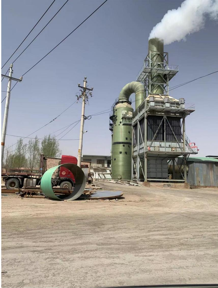
图 3-1 隧道窑、干燥窑烟气治理设备及排气筒照片
