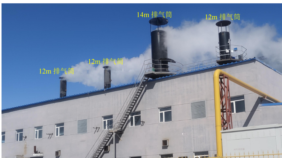
图 3-3 锅炉排气筒照片
