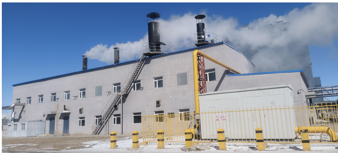
图 3-1 锅炉房现场照片
