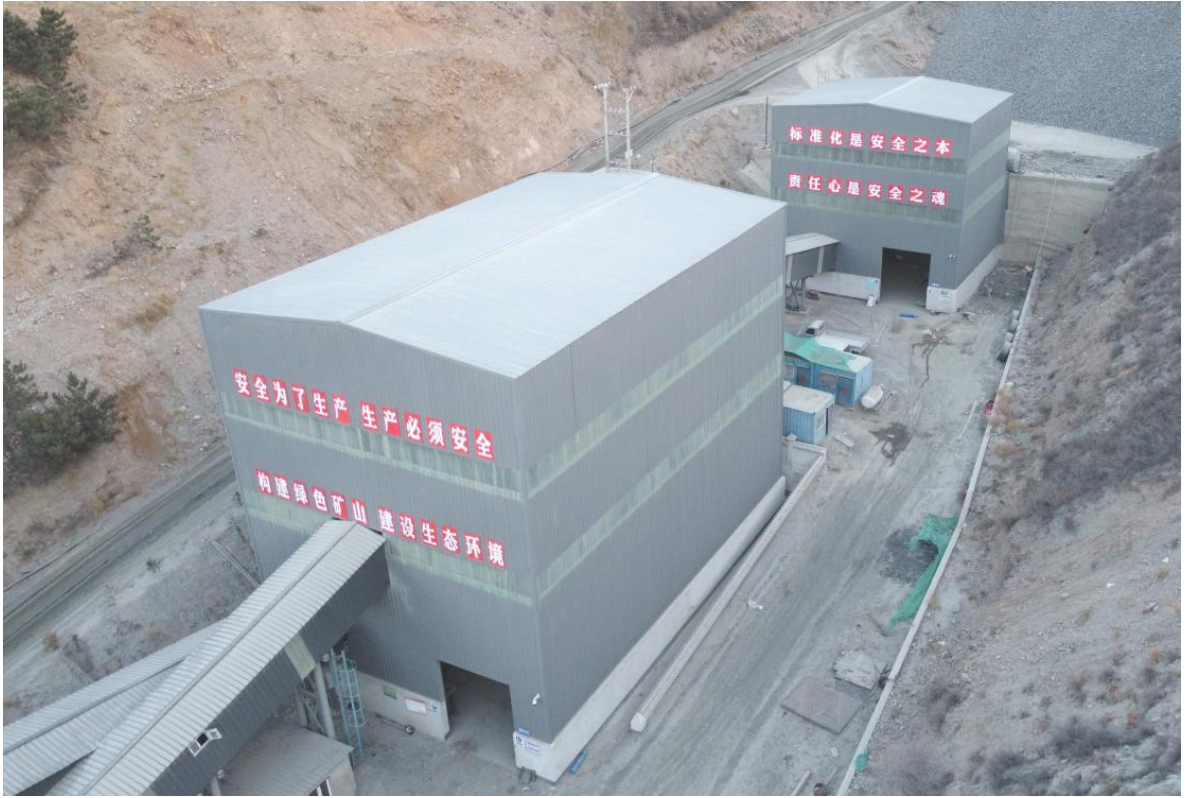
图2.5-3 破碎车间照片
