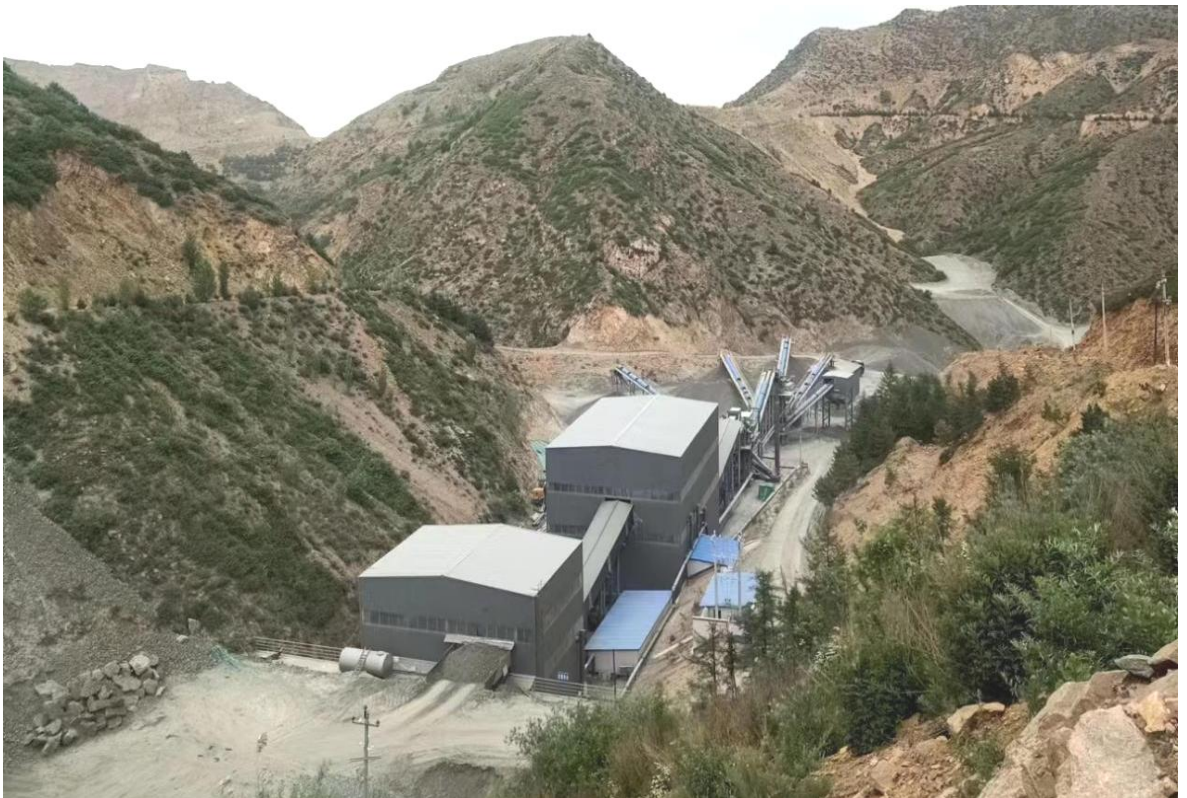
图2.5-2 矿山主体工程照片
