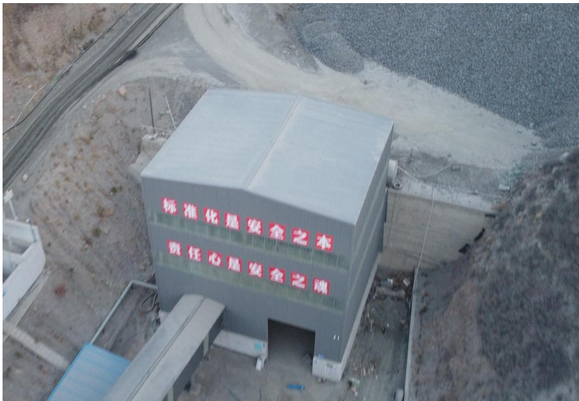
4.1-5 噪声封闭式厂房照片
