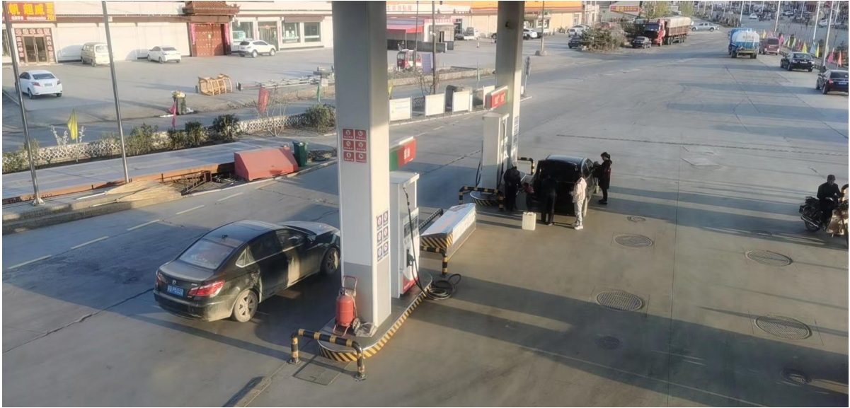
图 2-1 项目现场照片
