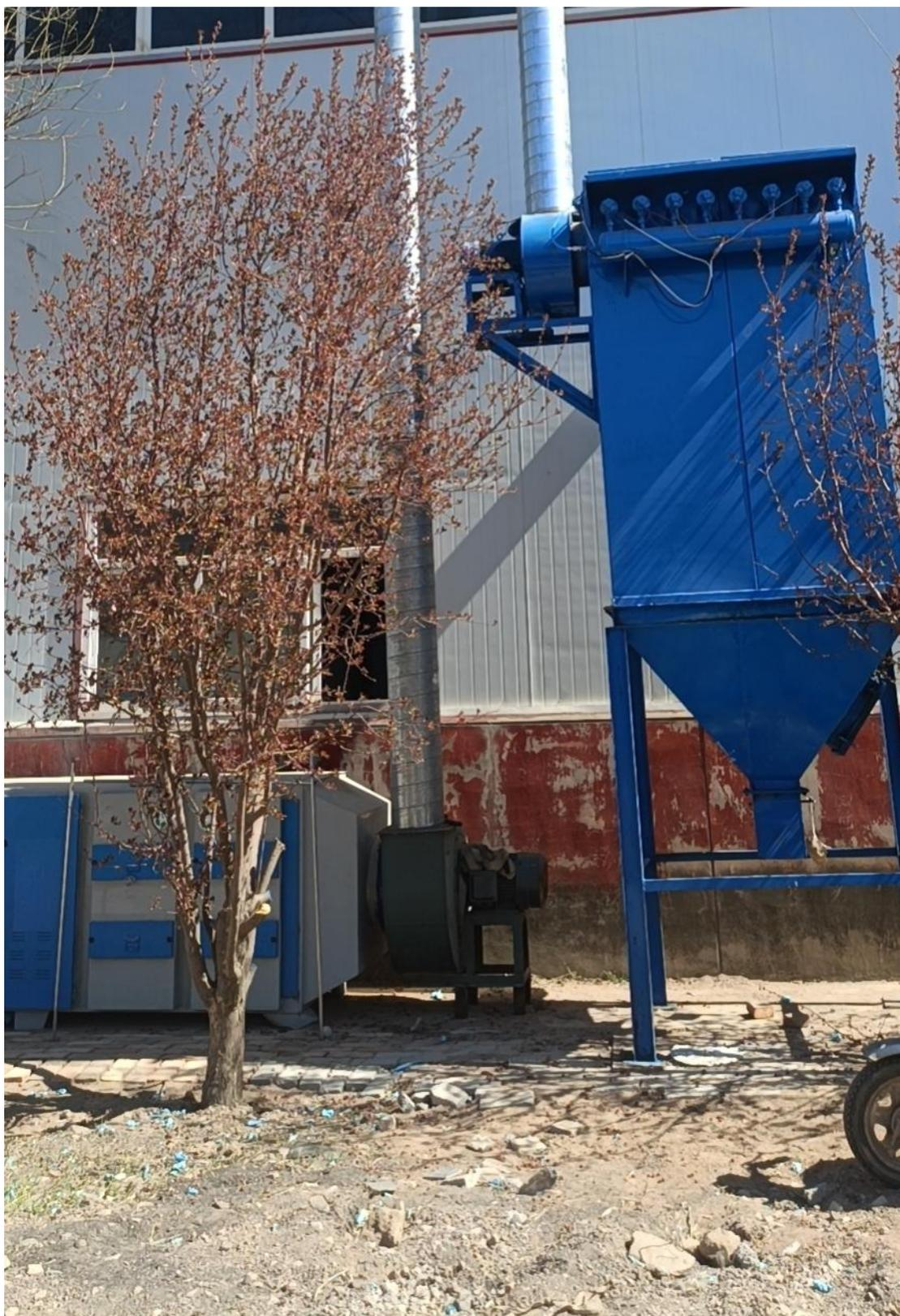
图 3-2 除尘器及有机废气治理设备现场照片
