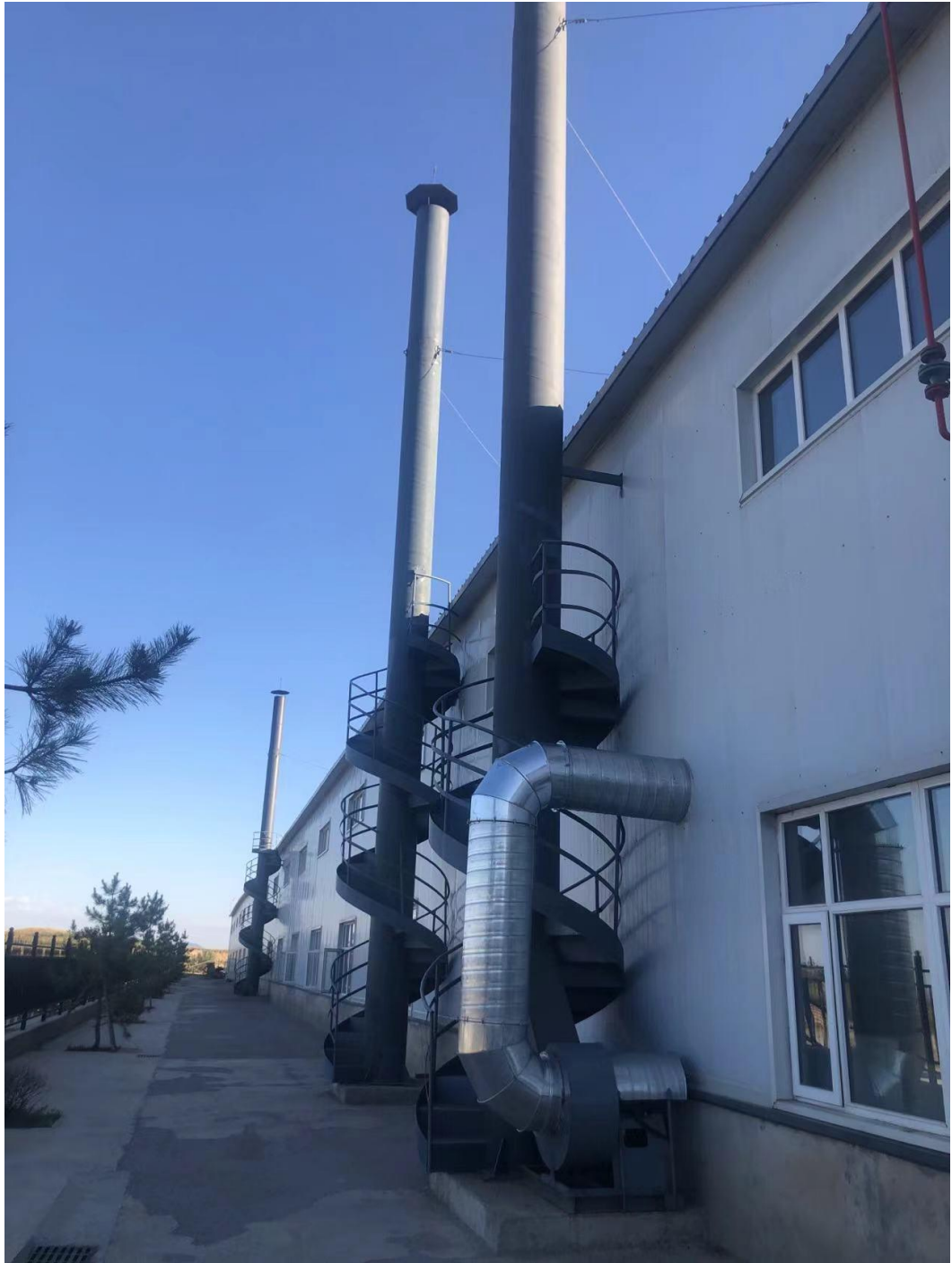
图3-2烘干、喷塑、喷砂三根排气筒
