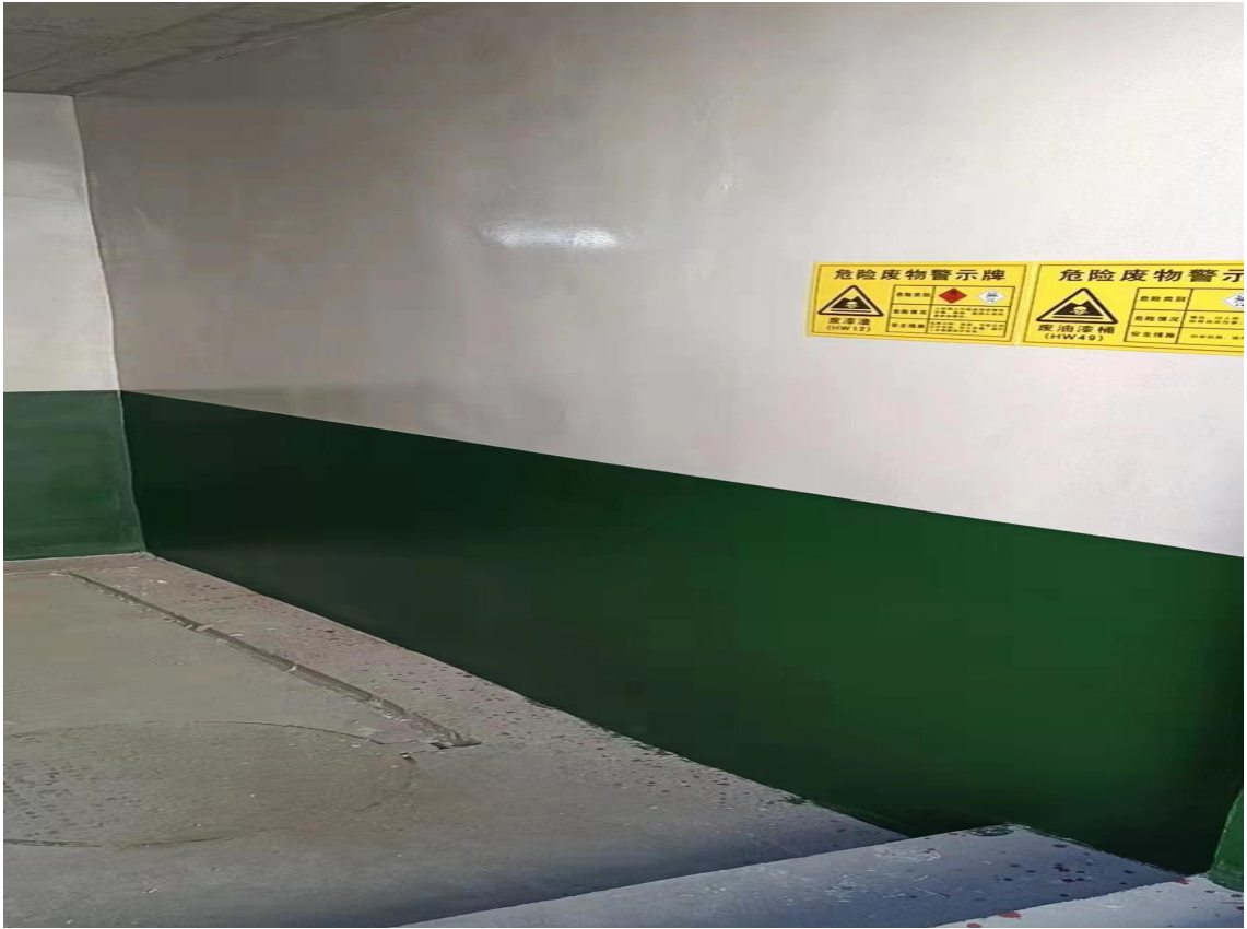
图 3-9 危废间内部照片
