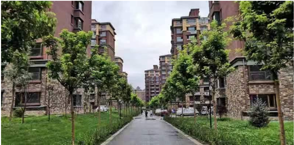
图 2-1 楼体现场照片
