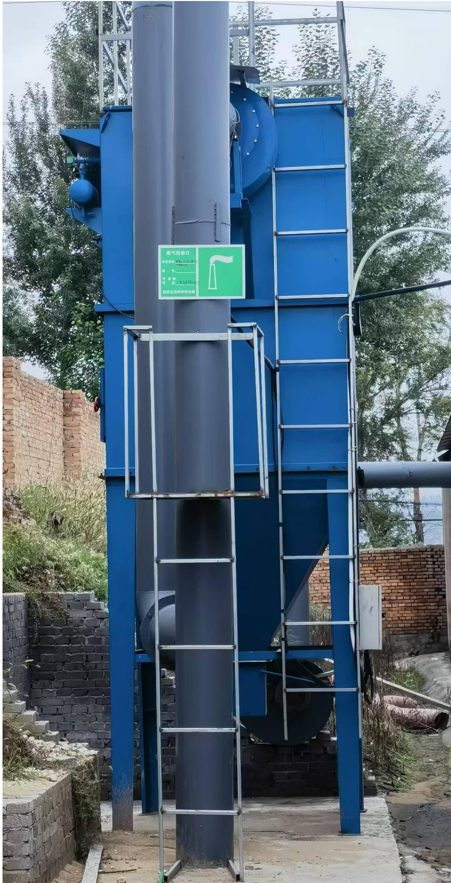
图 3-1 排气筒现场照片
