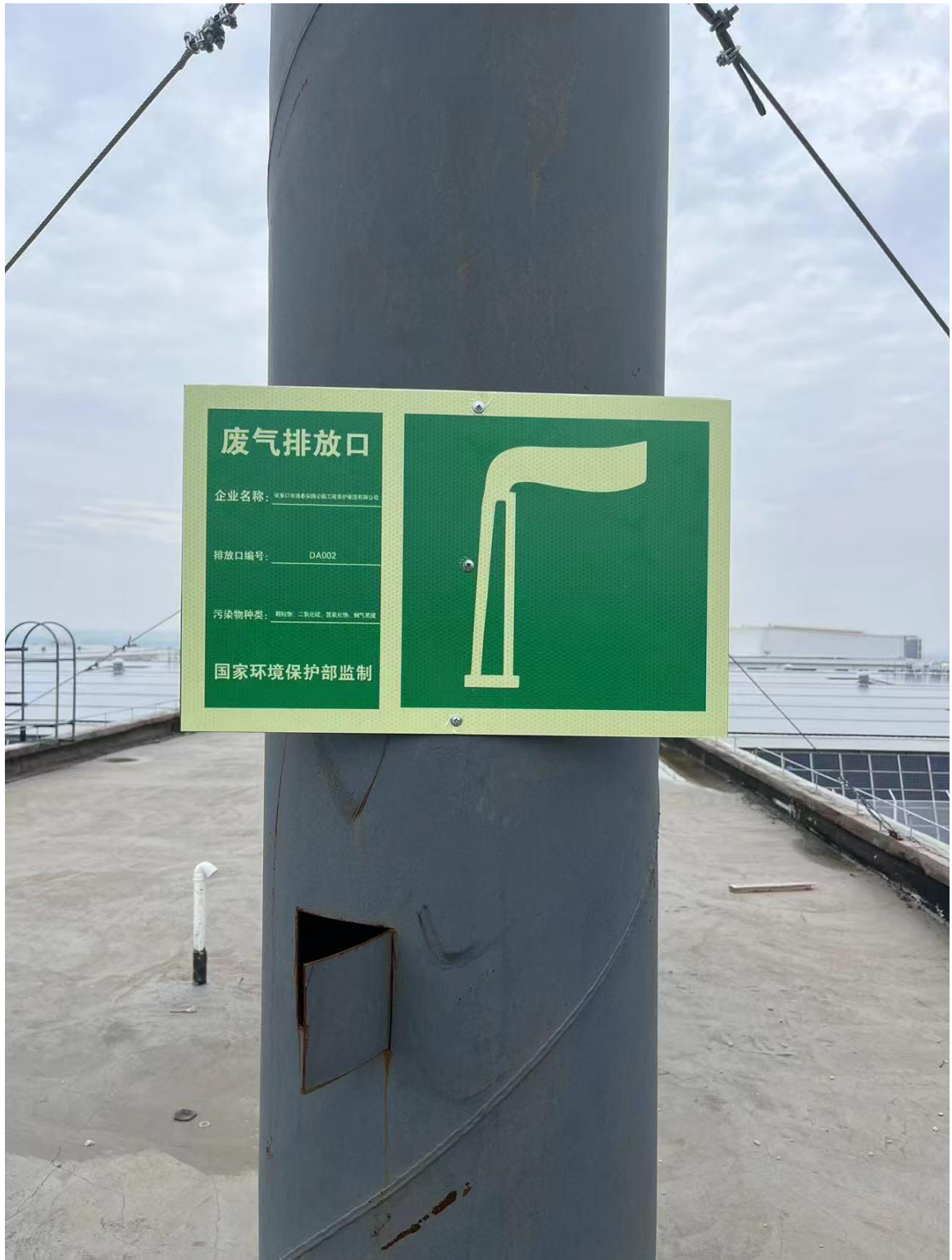
图 3-5 废气排放口现场照片 (P2)
