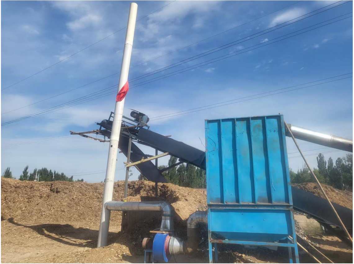
图 3-2 项目现场排气筒照片
