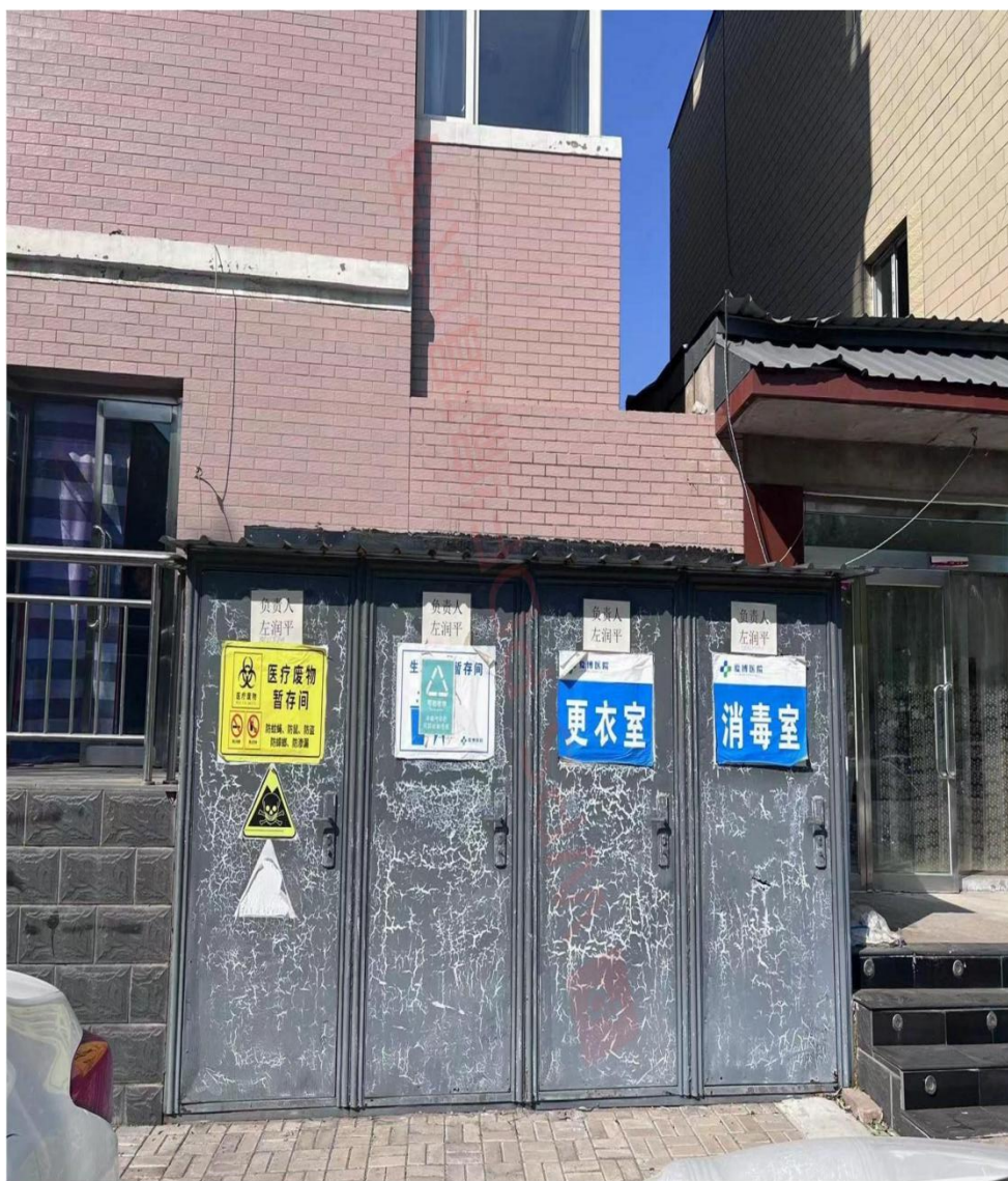
危废间外面照片
