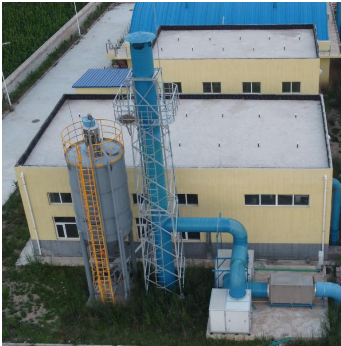
图 3-1 除臭废气治理设备及排气筒照片
