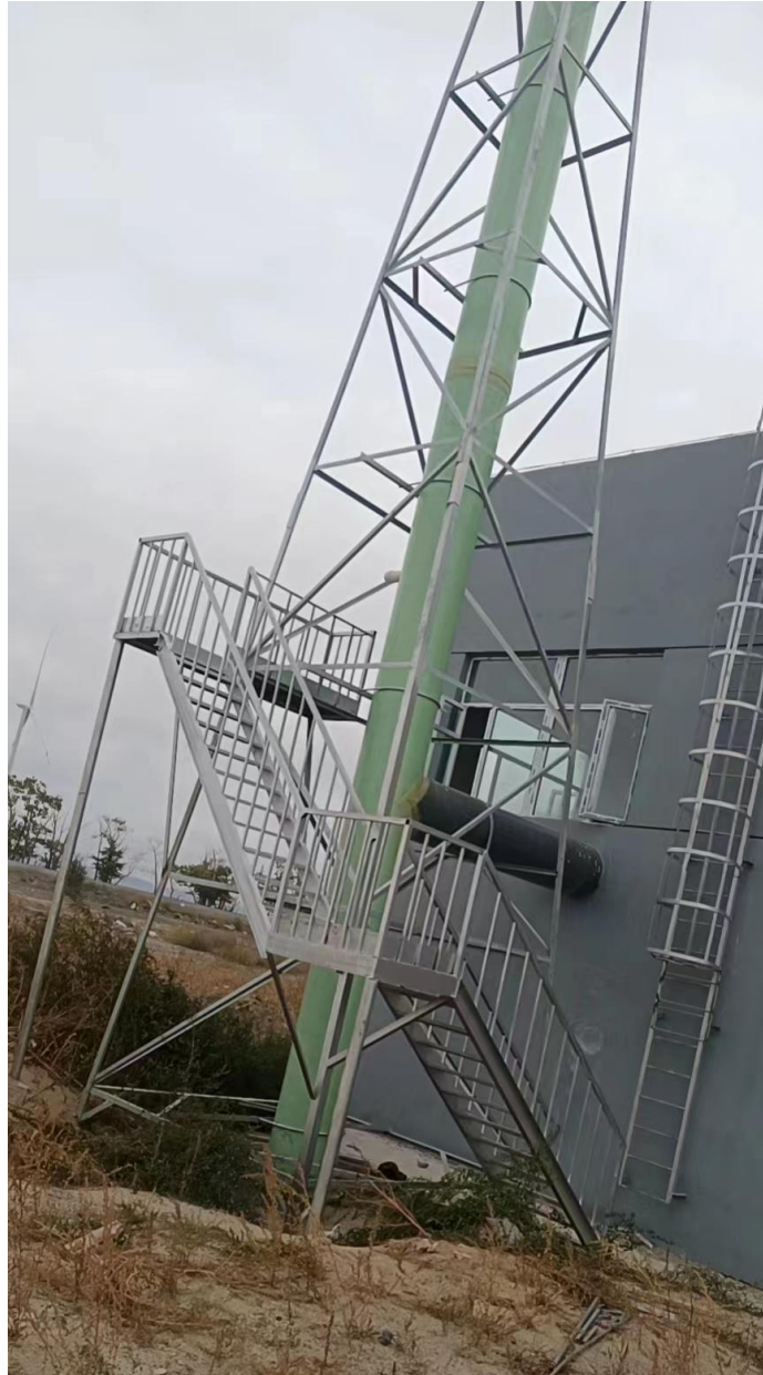
图 3-1 废气排气筒
